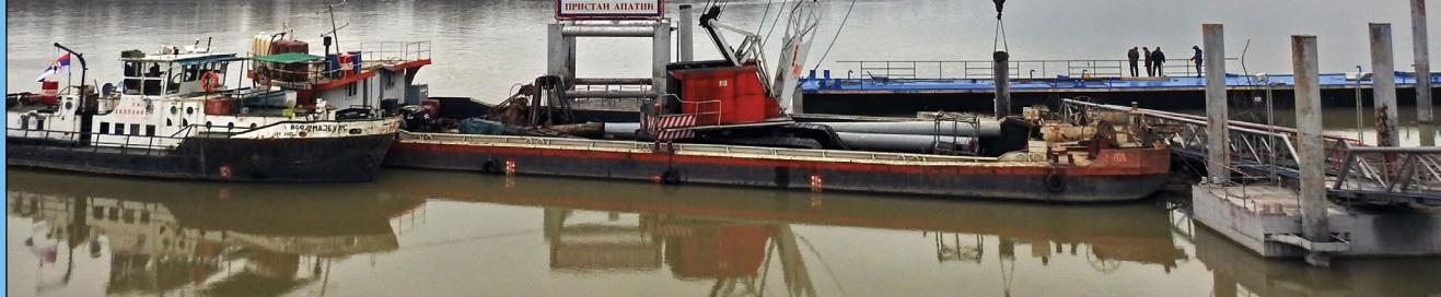
**Č**elična konstrukcija, 53 metra duga platforma, ograda, bitve i sva ostala prateća oprema pristana je u Apatinu gde su počeli radovi na montaži pristana. Priprema je obavljena u Umci gde izvođač radova PD MIP „Grading“ doo iz Obrenovca ima svoj pogon.
