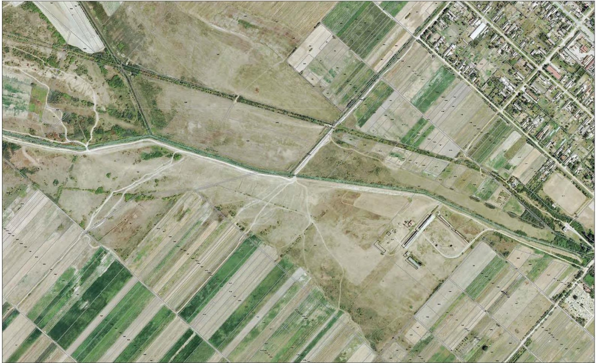
Слика 5: Локација Постројења за пречишћавање отпадних вода насеља Свилојево
